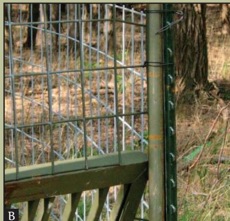
Use postes "T" para fijar la compuerta de cabecera (A). Asegure que la compuerta quepa de manera ajustada contra los postes "T" y fíjelo con alambre doble (B).
