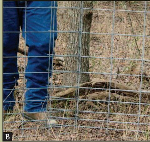
Un panel asegurado a un poste "T" de la compuerta de cabecera con alambre doble (A). Los paneles restantes se fijan entre sí. Es importante sobreponer los extremos de los paneles (B).
